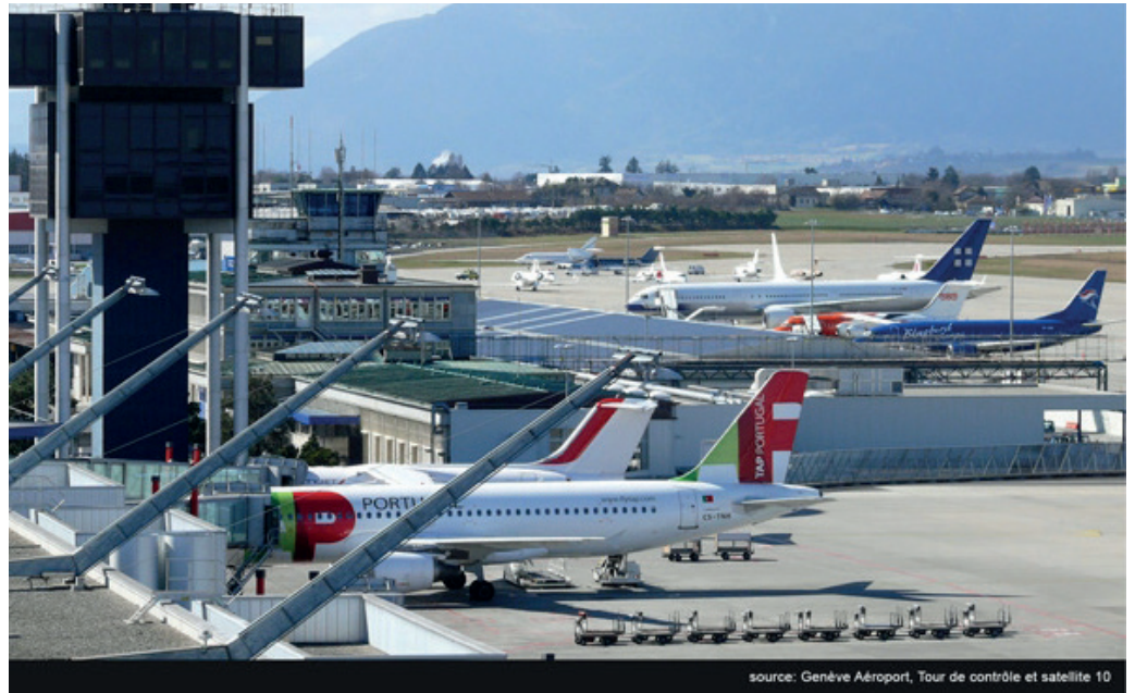
Kontrollturm am Flughafen von Genf-Cointrin.
